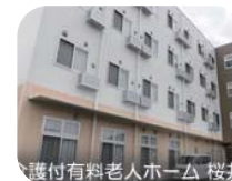
(株)クローバー 介護付有料老人ホーム 「四葉のクローバー 桜井」
